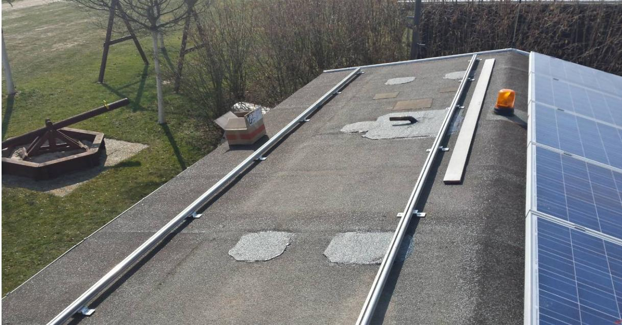
Die Dachsüdseite ist vorbereitet: Die neuen Solarzellen können montiert und angeschlossen werden
