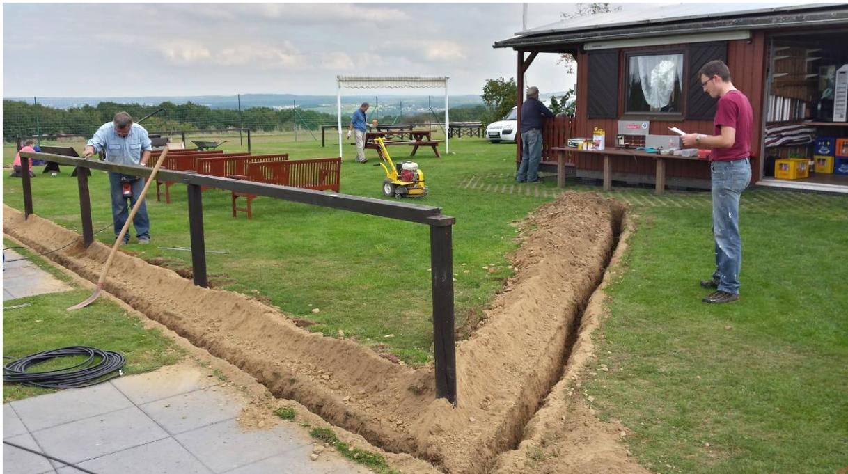
Erdreich fräsen für die Verlegung der 230V-Kabel entlang der Zuschauerabsperung
